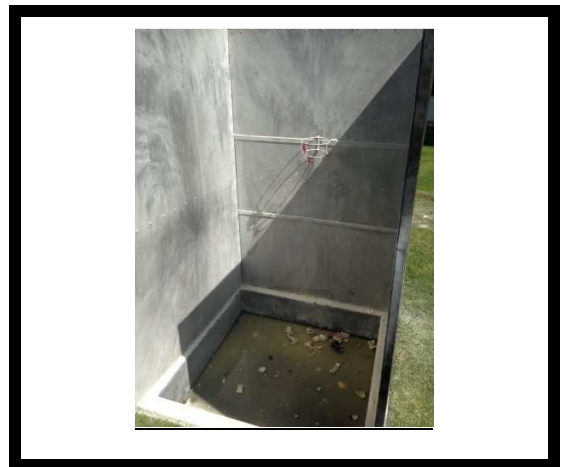
VISTA DEL MECANISMO DE EVALUACIÓN DESPUES DE LA PRUEBA
